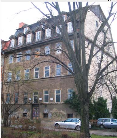
Ansicht Nord- und Westfassade vor Baubeginn
