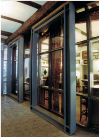
Stützkonstruktion der Holz- unterzüge von 1220
