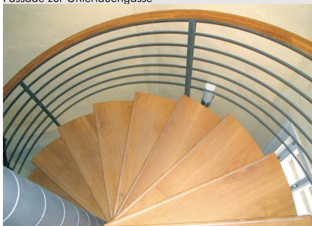
Wendeltreppe im sechseckigen Treppenturm
