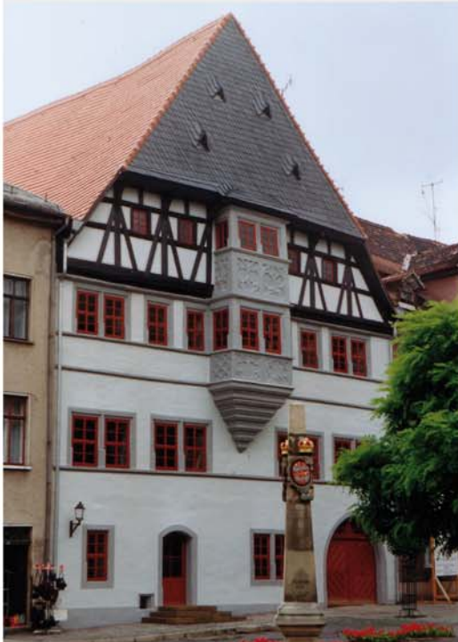
Ansicht von Westen nach Abschluss der Sanierungsarbeiten 1994
