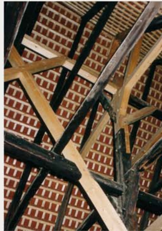
Dach nach Fertigstellung
